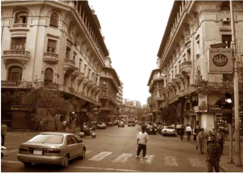
(شكل 17) العمارات الخديوية بشارع عماد الدين في حاجة إلى الترميم وإعادة التوظيف لإحلال الاستعمالات غير المناسبة لها مثل الورش الملوثة للبيئة والمخازن
